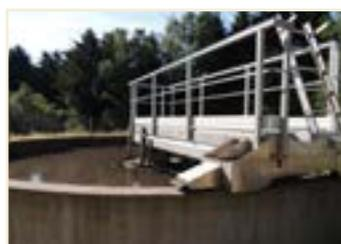
Le clarificateur est placé en sortie du bassin d'aération. Il a 3 fonctions : séparation de la boue et de l'eau épurée, une 2ème permettant ensuite une recirculation des boues concentrées vers la zone anoxie et enfin un stockage temporaire des boues.
